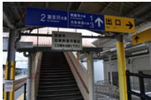
写真7「粟生駅の跨線橋」
