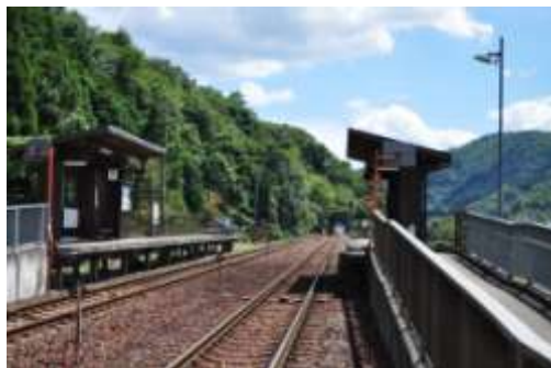
写真 25 「平福駅ホーム」
