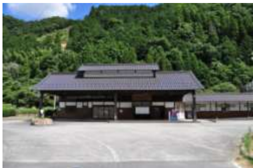
写真 24 「平福駅待合室兼トイレ」
