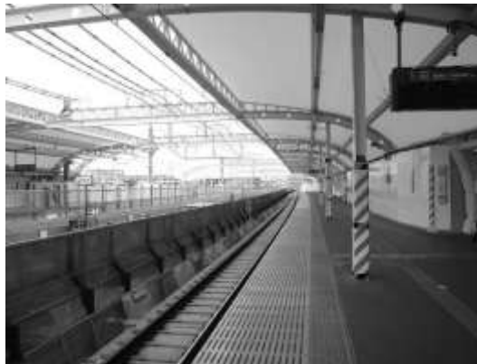
写真5 「複々線化工事が進む田園都市線の駅」
